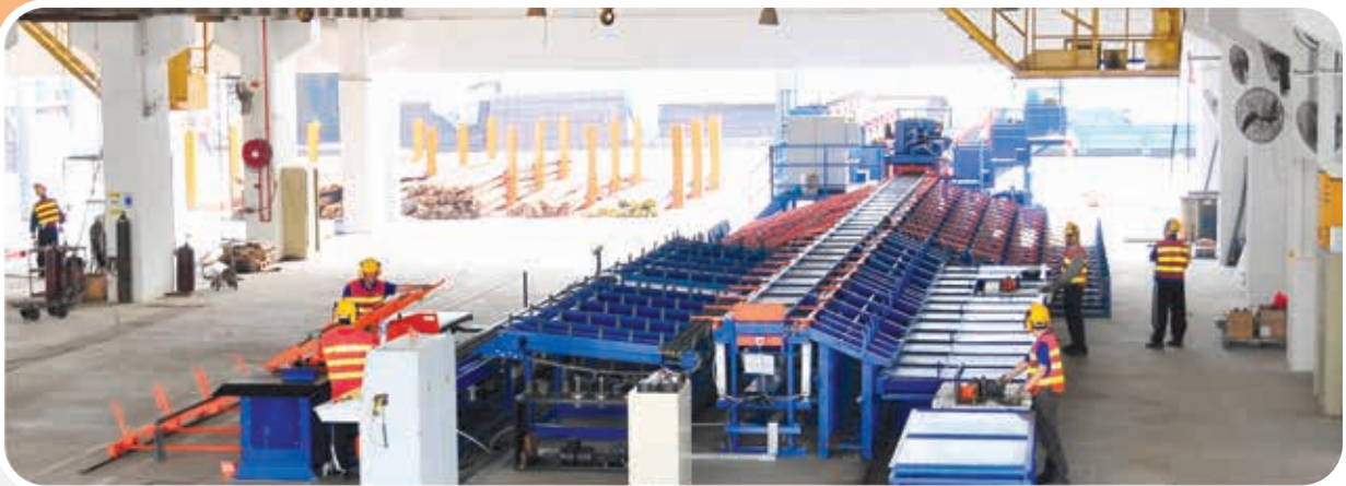
香港大埔之鋼筋自動化加工工場
